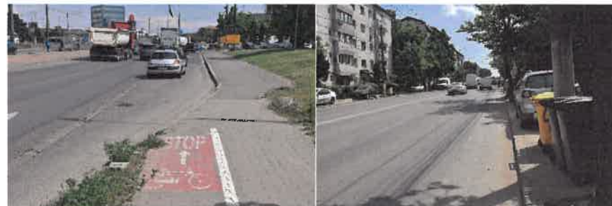
Figura 74: Pistă de biciclete care se termină înainte de o intersecție (Bulevardul Liviu Rebreanu) / Pistă de biciclete uzată până la nerecunoaștere (Calea Martirilor 1989)
