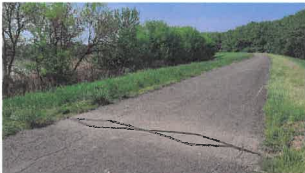
Figura 162: Contor de biciclete instalat pe un dig de protecție împotriva inundațiilor (Sarud, Ungaria)
