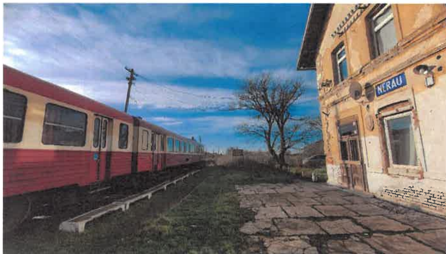
Figura 88: Stația de cale ferată Nerău
