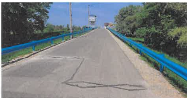
Figura 163: Contor de biciclete instalat pe un drum cu trafic redus (Kisköre, Ungaria)
