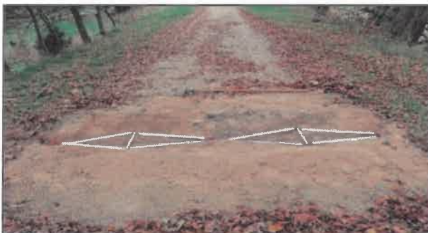
Figura 164: Buclă de inducție incorporabilă în drumul neasfaltat
