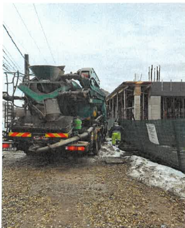
Construire Stația de Pompieri Făget
