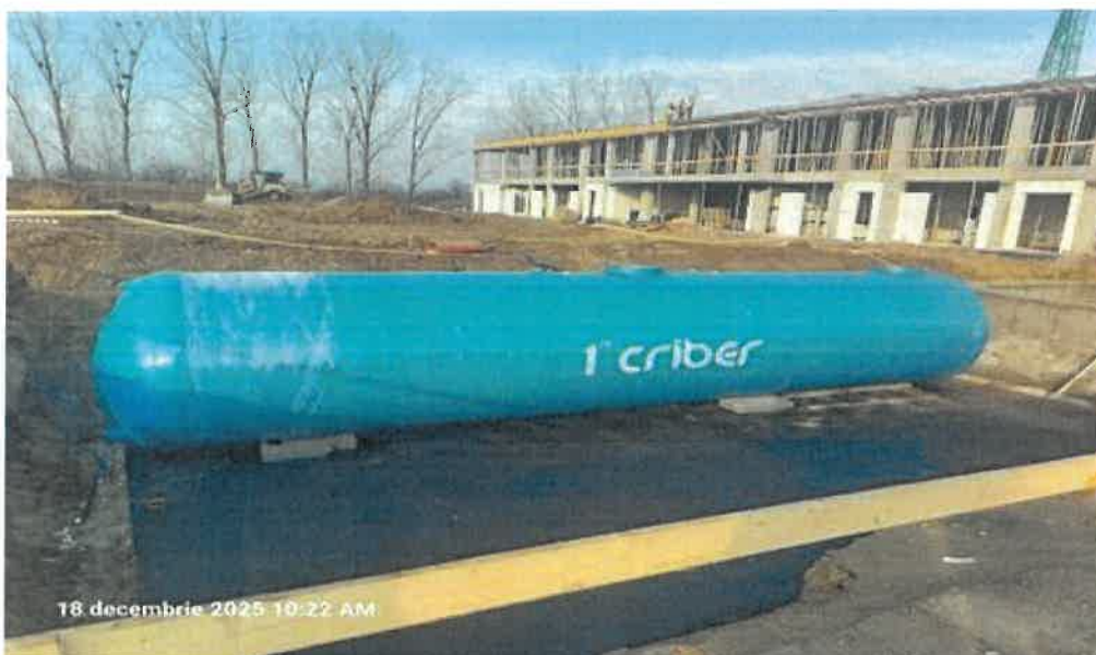
„Construire imobil - Centrul Școlar pentru Educație Incluzivă Dumitru Ciumăgeanu”
