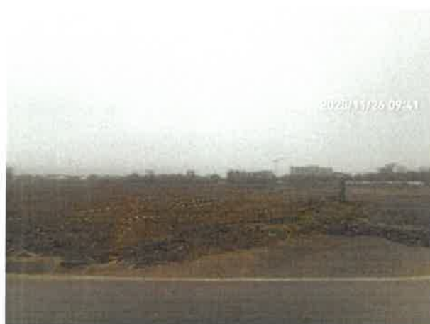
Lucrări desființare construcții existente Stadion „Dan Păltinișanu”
