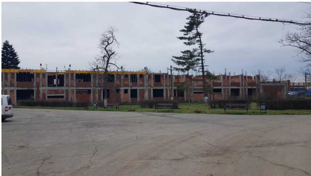
Construire clădire internat școlar CSEI „Al. Roșca” Lugoj
