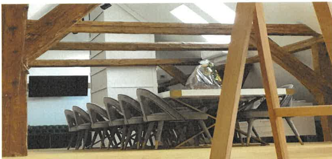
Lucrări de reabilitare acoperiș și realizare de spațiu expozițional la CECART
